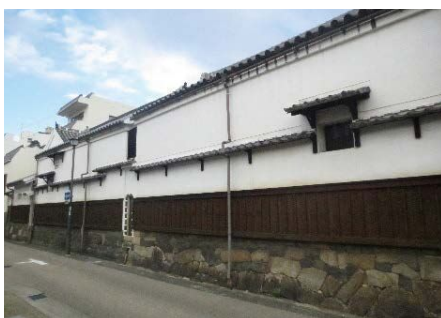
四間道 伊藤家
