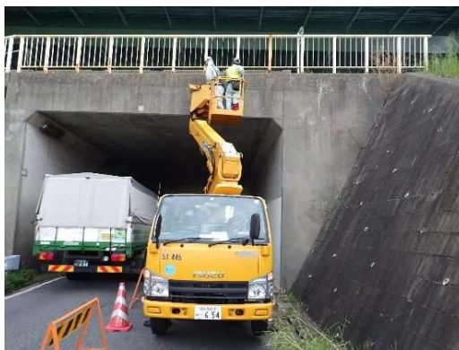
高所作業車による点検
