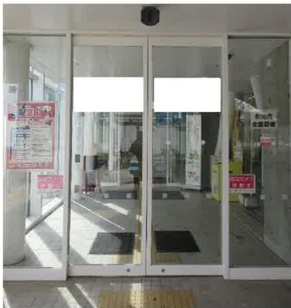
G 1階 庁舎内中央出入口自動開閉扉上部 扉面
