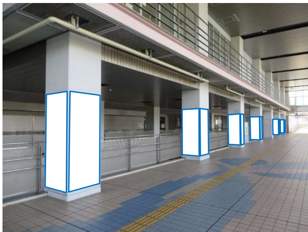
角柱（通路東側）
