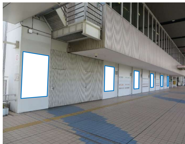
壁面（通路東側）
