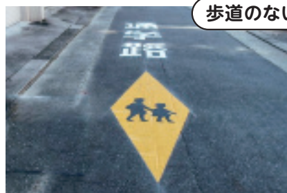
「通学路」の路面標示
