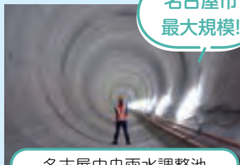
名古屋中央雨水調整池
