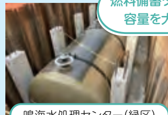
鳴海水処理センター(緑区)
