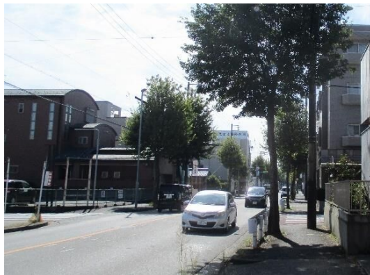
【撤去前】歩道有効幅員 1.47m
