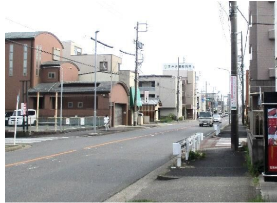
【撤去後】歩道有効幅員 2.67m(最大)
