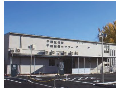
▲千種区役所仮設庁舎
