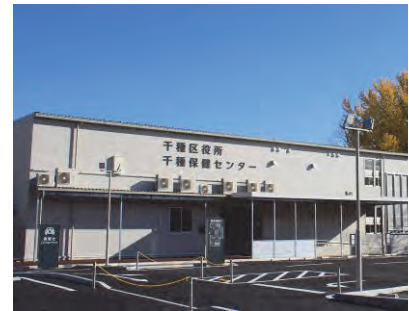
▲千種区役所仮設庁舎
