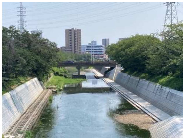
工事が進む可和名橋付近の様子
