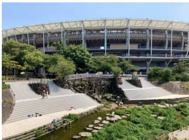
リニューアルが進む親水広場付近の様子
