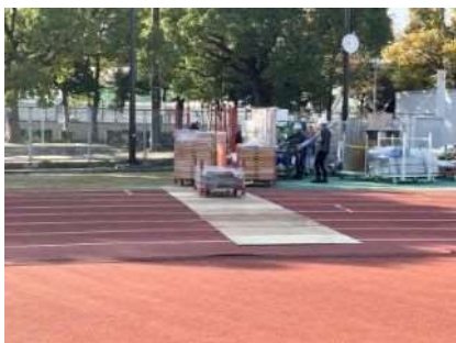
コンパネによる養生
