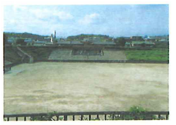
4 扇川公園 (雨水調節池)
