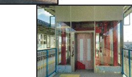
エレベーター 上下線に各1台設置
