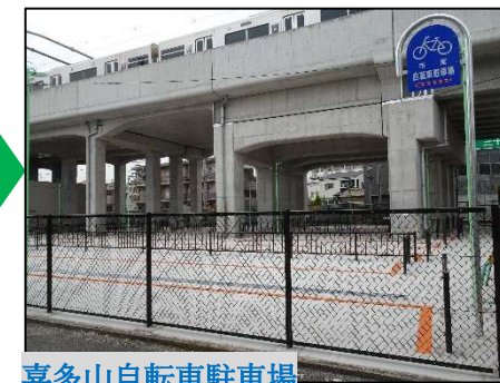
喜多山自転車駐車場
