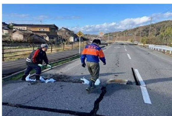
亀裂の入った道路を補修の様子
