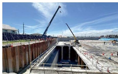
配水池を耐震化する工事
