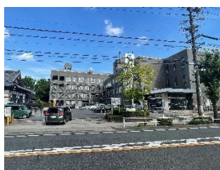
東区役所外観(西面)
