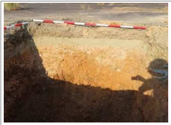
A-2 掘削断面（北側） W=2.0m H=1.5m
