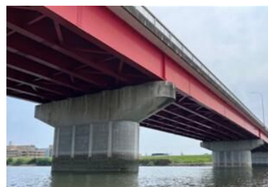
橋りよの耐震補強
