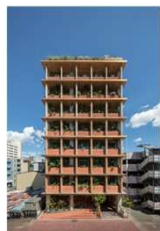
GOOD CYCLE BUILDING 001 浅沼組名古屋支店改修P J
