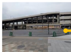
広場整備前 (解体工事完了後)
