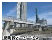
椿町線オーバーパス
