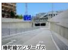
椿町線アンダーパス
