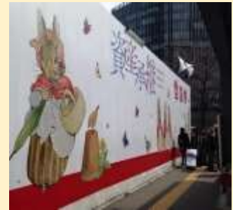
③工事用仮囲い広告
