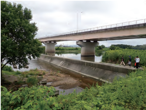
図3. 吉根堰堤と神明樋門手前の砂地
