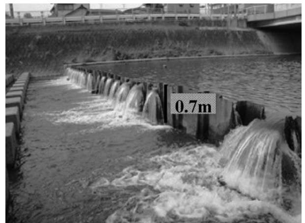
図6. 落差工B上流側の形状
