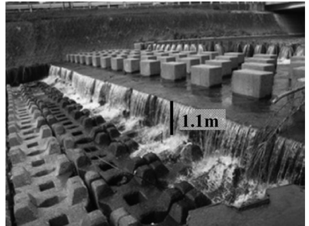
図5. 落差工Bの下流側の形状
