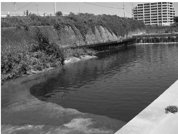
図3. 落差工A下流部高水敷周辺の植生帯の様子
