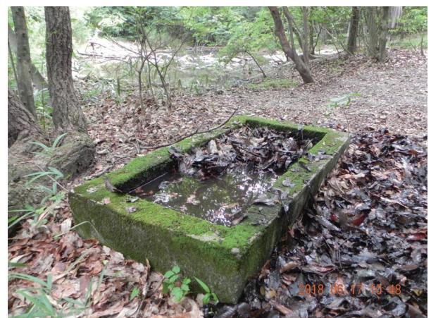
図14. 上端 沢止め池と防火貯水槽
