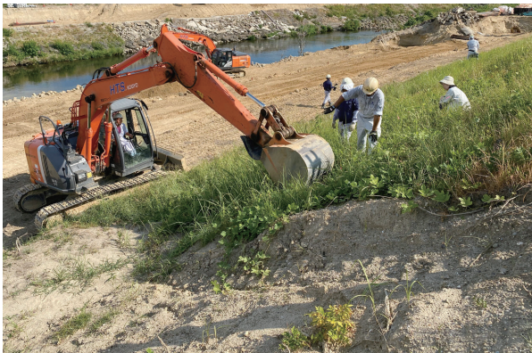
図2. バックホーを使った掘り出し作業.
