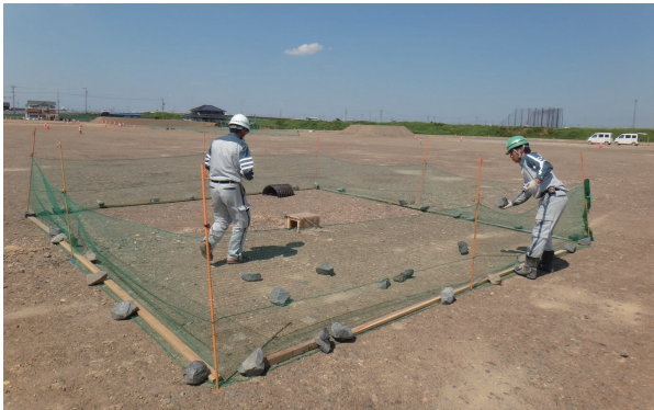
写真6 営巣箇所に保護ネット設置
