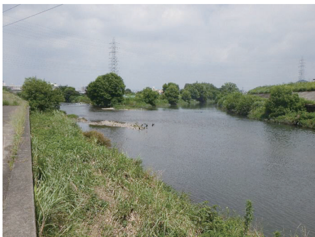
図2. 下流側からのSt.1 遠景. 右が新地蔵川に至る新川.
