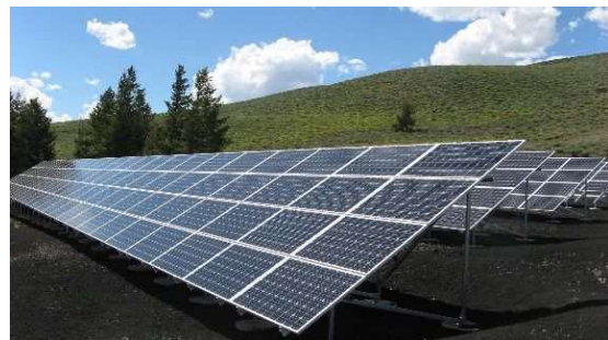
ご利用例：太陽光発電設備の設置
