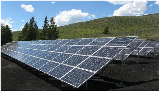
ご利用例：太陽光発電設備の設置
