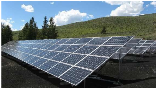
ご利用例：太陽光発電設備の設置
