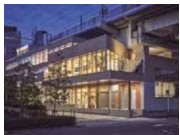
2 ささしま高架下オフィス
