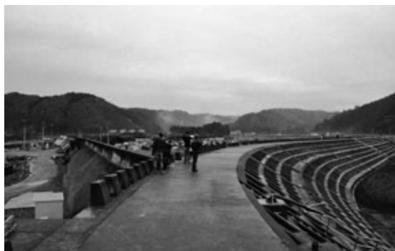
田老の10m堤防
