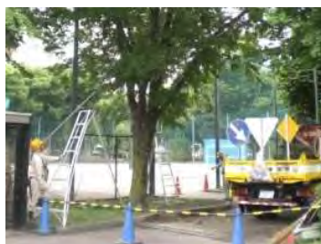
■補修班の作業状況
