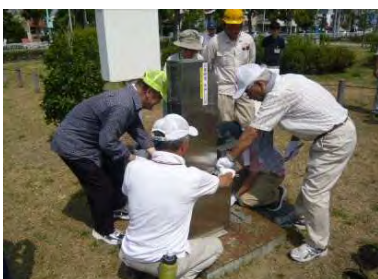
■井戸ポンプの組み立て
