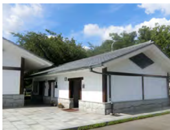
■ トイレ外観 (名古屋城正門前駐車場)
