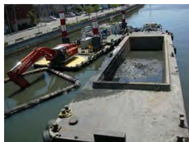
■河床掘削にあわせたヘドロ除去
