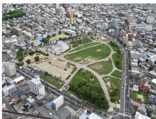
■ 防災機能を発揮するみどり (防災公園：川名公園（昭和区）)
