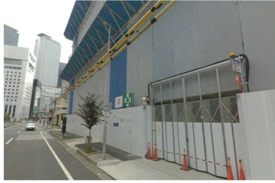
写真Ⅱ-10：清正公通のビル建設
