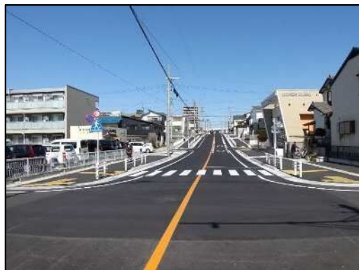
小幡西山線（整備後）
