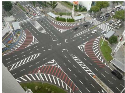
栄交差点（整備後）
