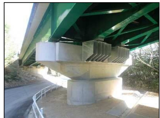
東山橋（整備後）
