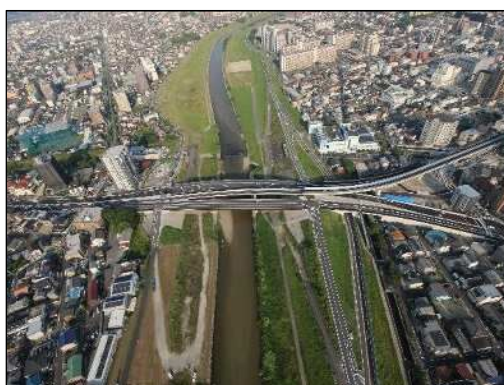
三階橋（整備後）
