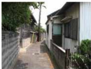
狭あい道路沿いのブロック塀
