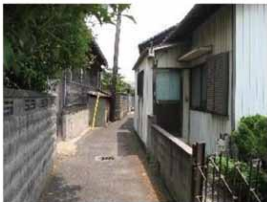
狭あい道路沿いのブロック塀
