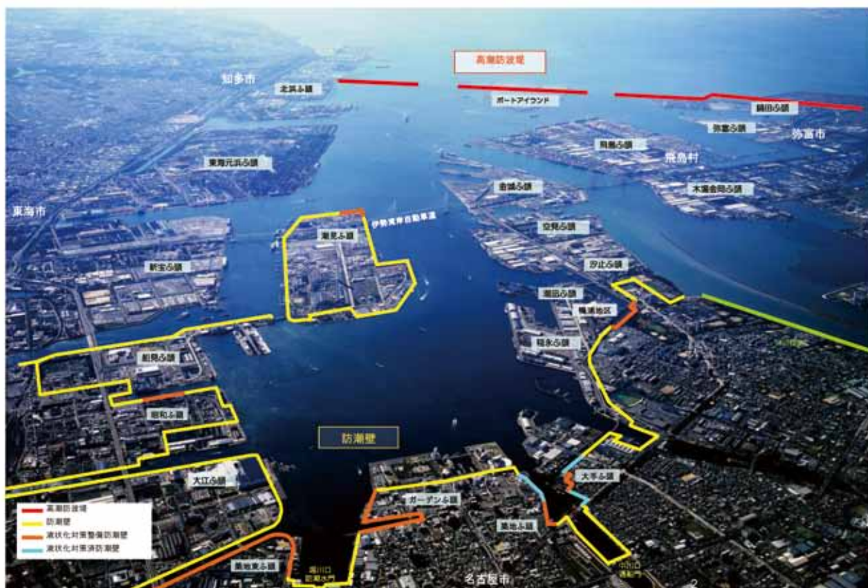
名古屋港の津波防護施設
