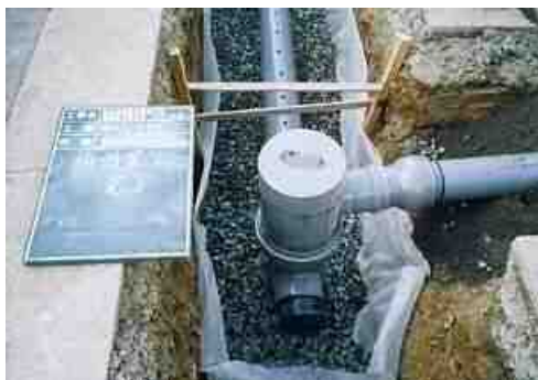
■ 雨水浸透ますを設置する様子
