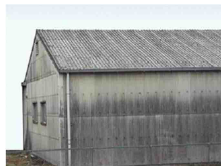
■石綿含有成形板（スレート屋根）
