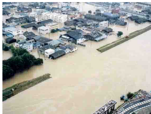
■東海豪雨による被害の様子 （西区あし原町の新川決壊箇所）
