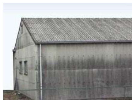
■石綿含有成形板（スレート屋根）
