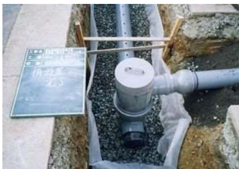
■ 雨水浸透ますを設置する様子
