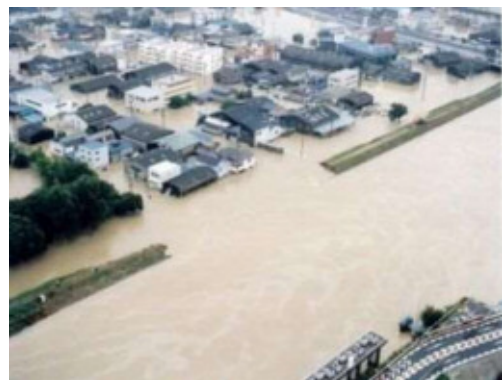
■東海豪雨による被害の様子 （西区あし原町の新川決壊箇所）
