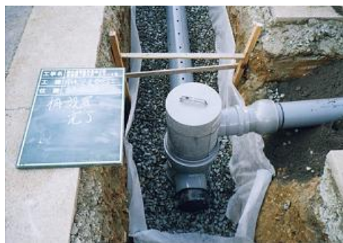
■ 雨水浸透ますを設置する様子
