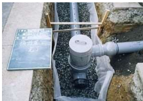
■ 雨水浸透ますを設置する様子
