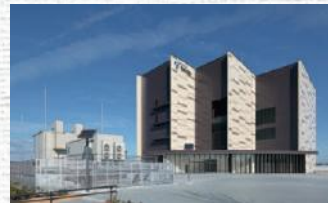
エネルギーセンター
