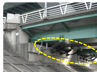
橋りょうの耐震補強の例
