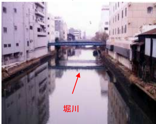
写真-1.19 洲崎橋付近
