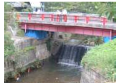
写真-1.9 猿投橋と落差工
