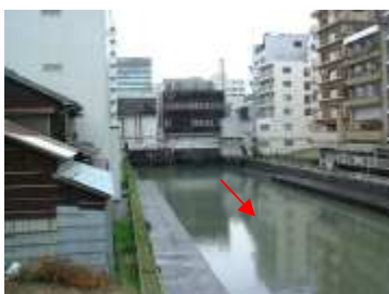
写真-1.13 堀留水处理センター下流
