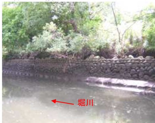
写真-1.20 日置橋付近
