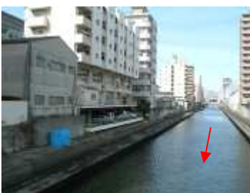
写真-1.14 富士見橋(4.85k)下流
