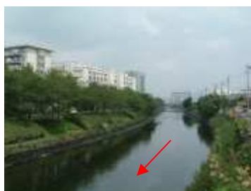
写真-1.15 新堀田橋(2.44k)下流
