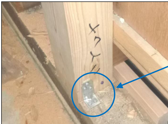
No. 4 壁① 1階 X7-Y11 柱下部仕口金物
