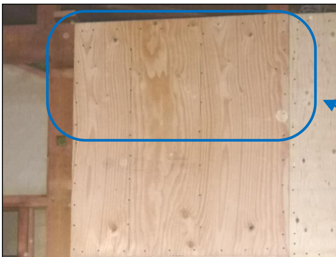
No. 8 壁① 1階 X7-Y10~11 構造用合板上部
