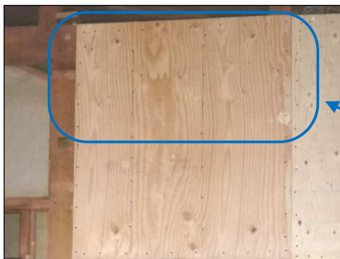
No. 8 壁① 1階 X7-Y10~11 構造用合板上部
