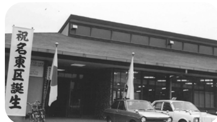
千種区猪高支所時代の本庁舎(現東庁舎)
