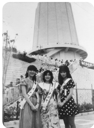
1984年 配水塔完成記念撮影会
