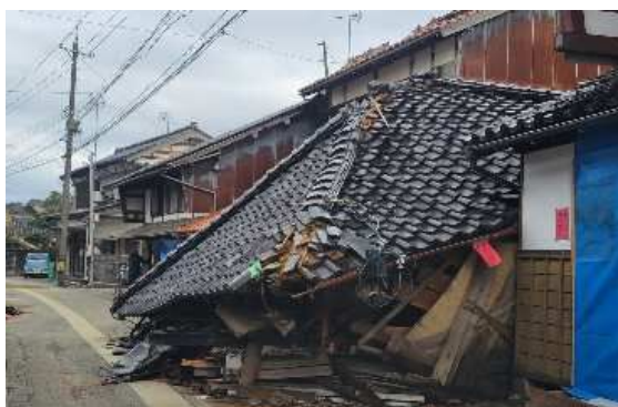
被害が大きかった地域 （赤紙が貼られた家屋）
