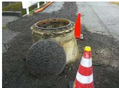
【下水道】 液状化によるマンホール浮上
