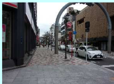
七間町通(歩道拡幅)
